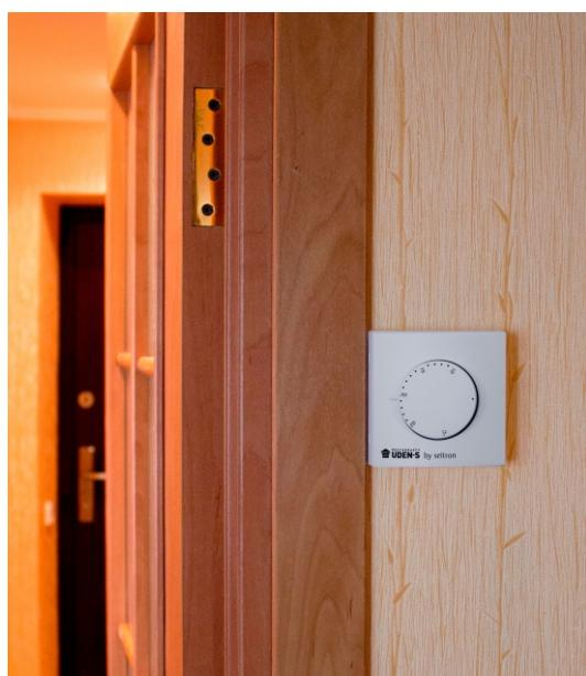
Електромеханічний терморегулятор SEITRON TM 001M в інтер'єрі
